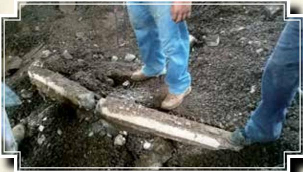
**2. Columnas inapropiadas:** A pesar de ser un tramo de mas de doce metros, la pared se levanto con columnas de tubos de cuatro pulgadas con vigas intermedias de uno o dos elementos de hierro de 3/8 que no daban la fortaleza necesaria a la estructura.
