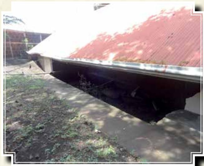
Foto: Al centro de la Fosa 1, el colapso del muro fue de 13.72 metros de longitud x 3.42 metros de altura (porque incluye la altura de 1.30 metros del muro de 1942, más 2.12 metros de altura del muro de los años 70).
