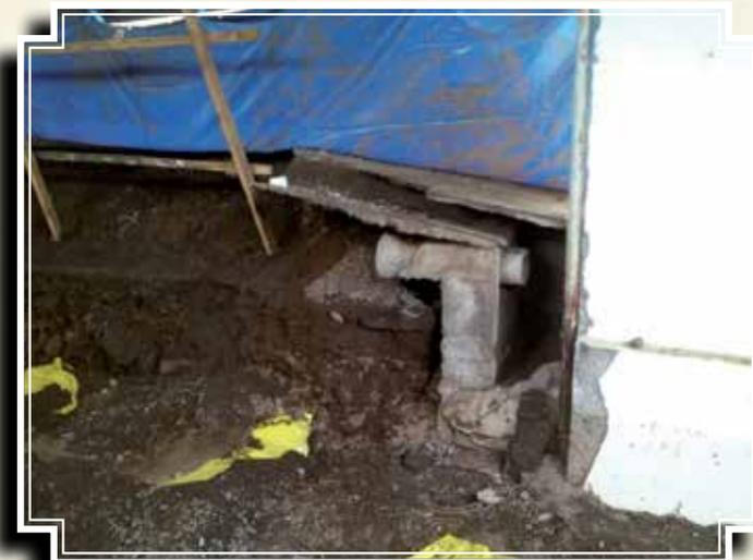
Existe la presencia de tuberías de concreto, las cuales se encuentran en mal estado, y están ubicadas de manera paralela al muro colapsado.
