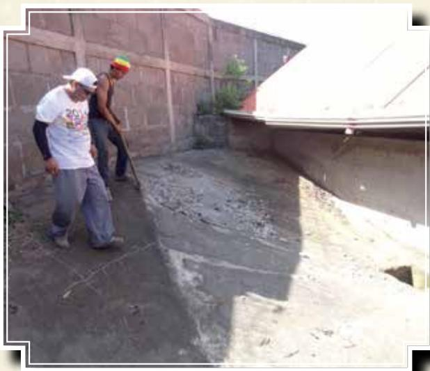
Foto: Sistema de drenaje pluvial obsoleto, en forma de embudo orientado hacia la Fosa 1. Debe ser eliminado.
