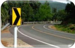
Para el cálculo del peralte hay que tener en cuenta principalmente el radio de la curva, el peso del vehículo y la velocidad del mismo, y con esto los ingenieros calculan las dimensiones para que los peraltes sean válidos para la mayor parte de los vehículos que transitan por una carretera. La importancia de estos peraltes puede comprobarse fácilmente si comparamos el tráfico de una carretera con el que se produce en un circuito de carreras.
